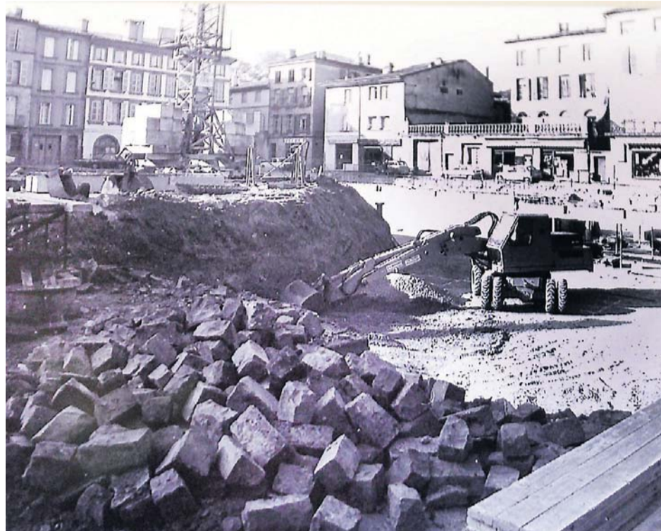
Les fouilles et les fondations ont été réalisées en 1984. / Photos DDM, archives, Chantal Longo.
